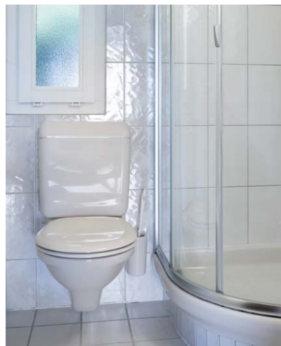
PŘED: WC se splachovací nádržkou na omítku
