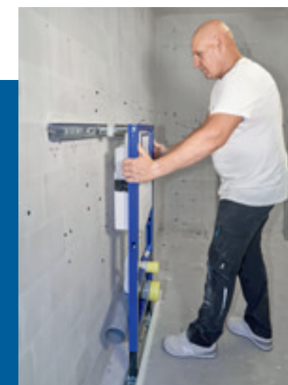
Régis Heitzler otáčí nástěnnou kotvu o čtvrt otáčky nahoru – zcela bez nářadí.
