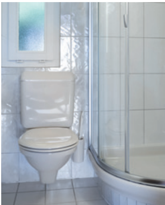
PŘED: WC se splachovací nádržkou na omítku
